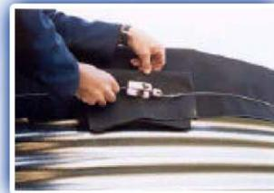
6. Con el revestimiento de caucho libre de arrugas, aplique el perfil de remate exterior a todo lo largo de borde superior del depósito, quitando los elementos provisionales de 75 mm de perfil de remate exterior a medida que vaya avanzando. El material colgando en el exterior deberá estar sin arrugas o tensiones; en caso contrario, será indicación de que el depósito tiene forma ovalada.
