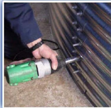
Verifique de nuevo para obtener un perfil circular. Con todos los paneles en posición, apriete todas las tuercas. Fije las escuadras de anclaje a la base de hormigón.
