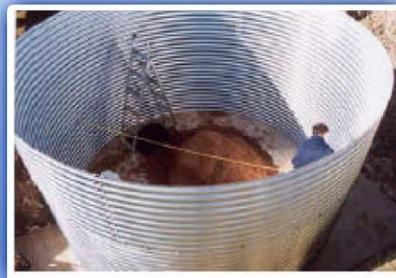
**7. Los anillos del segundo, tercer y cuarto nivel:** Cada anillo de paneles deberá instalarse en el exterior del anillo inmediatamente inferior, de manera que la junta de solape impida el ingreso del agua de lluvia.
