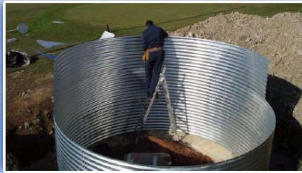
Es esencial que las uniones verticales de los paneles de cada anillo estén decaladas de manera a estar aproximadamente alineadas con el eje vertical medio de los correspondientes paneles de los anillos adyacentes, de forma similar a un enladrillado.
