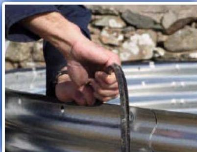
2. ANTES de trabajar con el revestimiento de caucho, compruebe que no haya piedras u objetos cortantes en el lecho de arena o en sus zapatos. Despliegue y extienda el revestimiento de caucho sobre el lecho de 50 mm de arena de forma que la junta entre la base y la pared lateral del revestimiento esté en contacto con los paneles del depósito en toda su circunferencia. Extienda entonces la sección de revestimiento correspondiente a la pared sobre la base.
