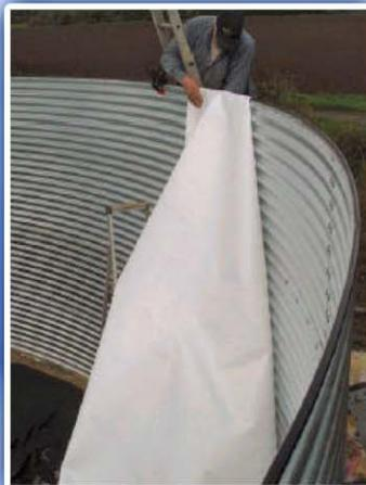
4. Proceda a repetir esta operación sucesivamente con los demás elementos de forro, asegurando un solape vertical de Los elementos de 25 cm de anchura, hasta cubrir toda la cara interior de la pared del depósito.
