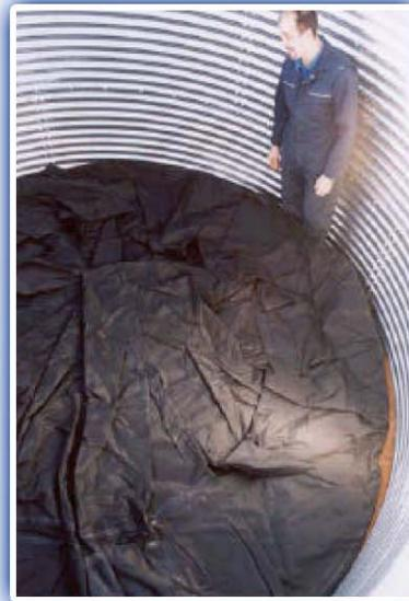
3. El instalador en el interior del depósito le alcanza al instalador subido a la escalera en el exterior el borde superior del revestimiento. El instalador en el exterior tira del revestimiento hasta tener aproximadamente 300 mm de revestimiento colgando del borde superior del depósito en el exterior, y sujeta así el forro en posición con elementos de 75 mm de longitud del perfil de remate exterior.
