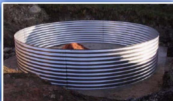
2. Ordene los paneles de chapa galvanizada en función del espesor de chapa. Cada panel está etiquetado con un código que denota su espesor, resistencia y diámetro del depósito. Por ejemplo, el código 16 25 36 indica un espesor de 1,6 mm, un acero de resistencia Z25 y un diámetro de 36 pies. Los posibles espesores de chapa son 1,6 mm, 1,2 mm, 1,0 mm y 0,8 mm.
