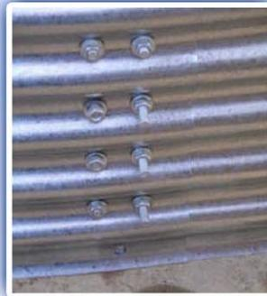
5. Fije las escuadras de anclaje en el exterior del depósito a cada junta vertical de los paneles inferiores empleando los pernos largos M10 x 40 mm y tuercas espaciadoras suplementarias. No fije las escuadras a la base de hormigón.
