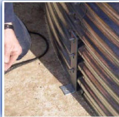
6. Verifique y ajuste el anillo para obtener un círculo de diámetro correcto. Apriete algunas de las tuercas para mantener los paneles en posición. No apriete todas las tuercas hasta tener el depósito enteramente montado.
